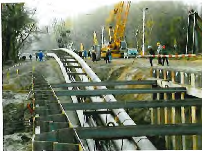
Gasleitungsbau durch die Donau u. Untere Fische 1999
