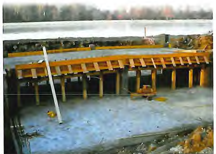
Bauarbeiten am Treppelweg für "Wasser in die Au" 1998
